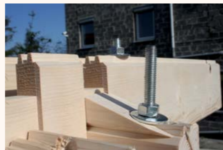
De wanden zijn gefixeerd middels draadstangen voor extra stevigheid.
